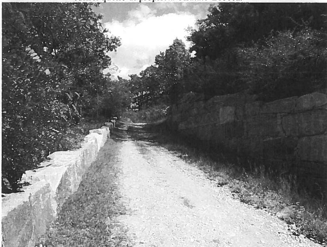
Fotografia n. 4 La viabilità di cava per il tratto immediatamente a monte degli edifici di proprietà Sfratato-Brocca. Si noti l'ampiezza del piano viabile e le opere di sostegno e di protezione realizzate a monte e a valle della stessa.
