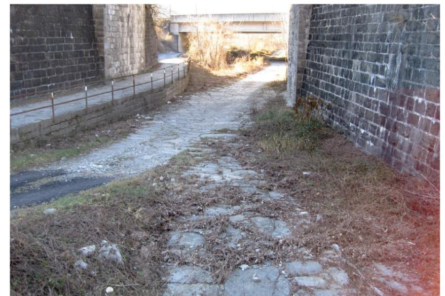
Foto 3: sottopasso ferroviario, potenzialmente allagabile per concomitanza di piene del Rio Molinetto e del F. Toce
