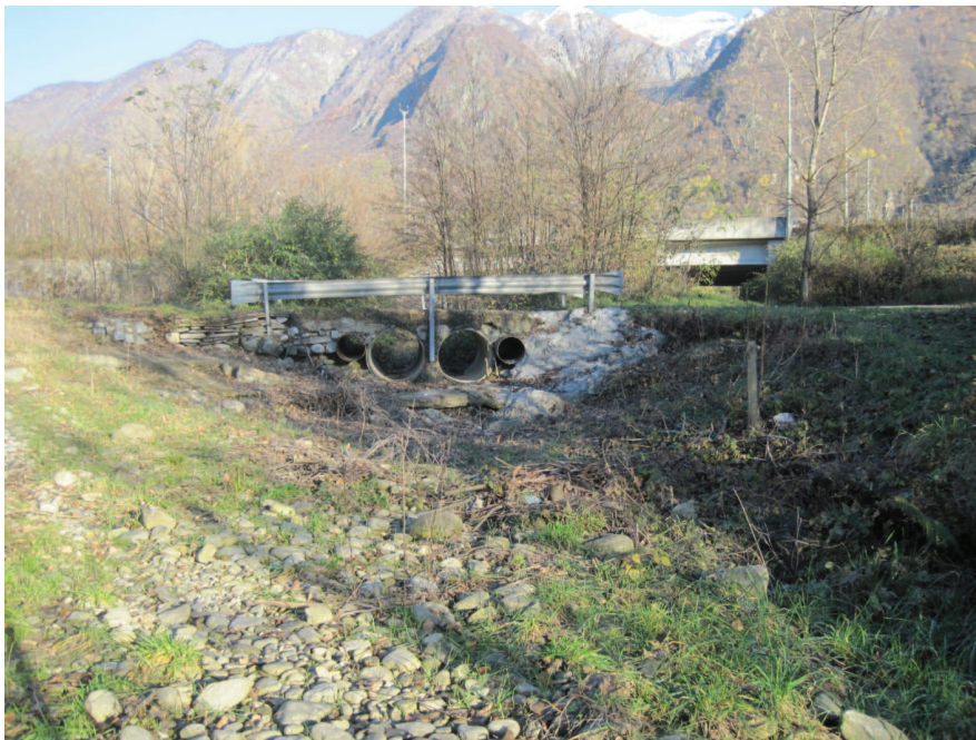
Foto 13: Veduta da valle dell'attraversamento della strada di accesso al laghetto.
