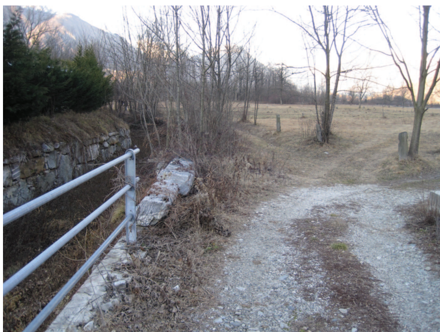
Foto 3: A partire da questo punto verrà prolungata la strada esistente ed inizieranno le operazioni di spostamento dell'alveo del corso d'acqua.
