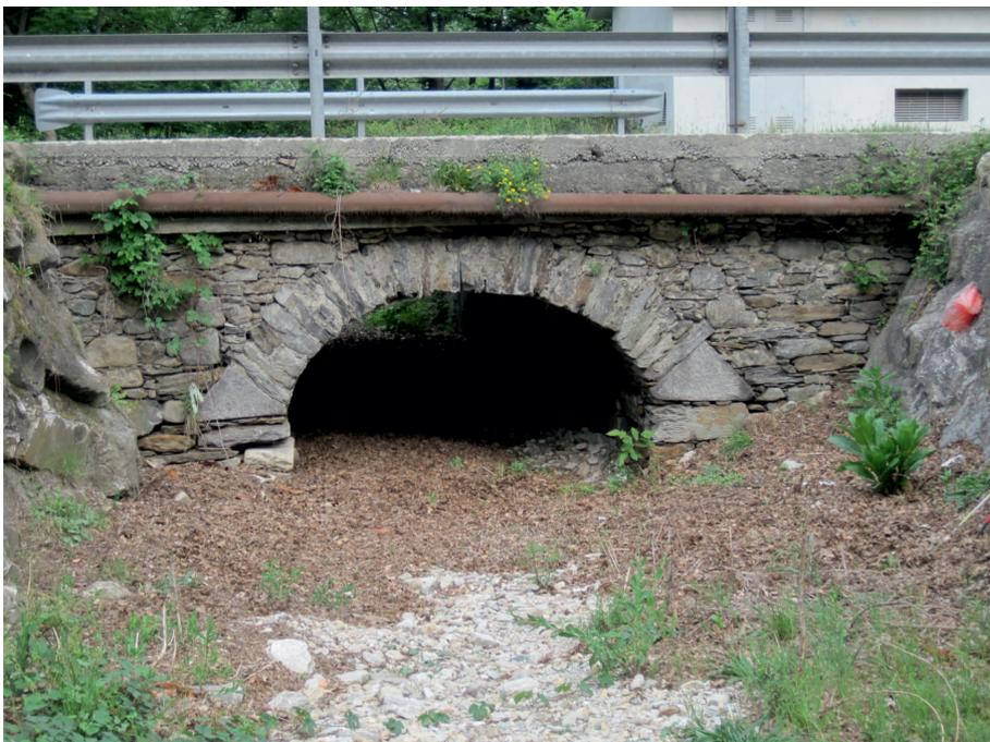
FOTO 5 - Imbocco del manufatto di attraversamento della Strada Provinciale, con sezione insufficiente
