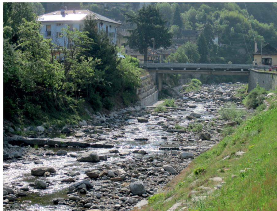
FOTO 1-2 - Settore d'alveo regimato in apice di conoide, a monte del ponte della S.P.
